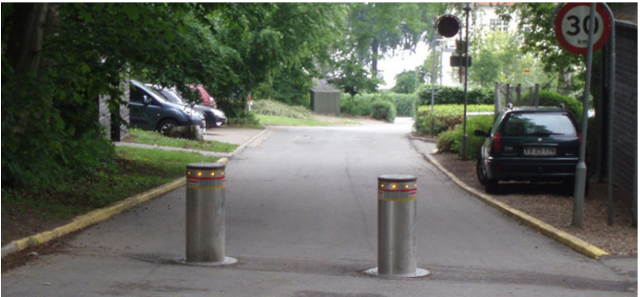
Eksempel på automatiske pullerter (foto Scan - agentur)
